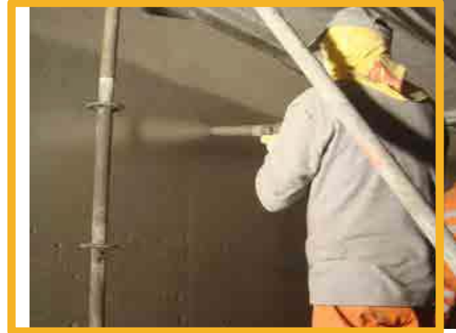
Thi công bằng phun
