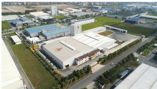
Nhà máy Bắc Ninh
