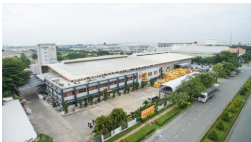
Nhà máy Nhơn Trạch
